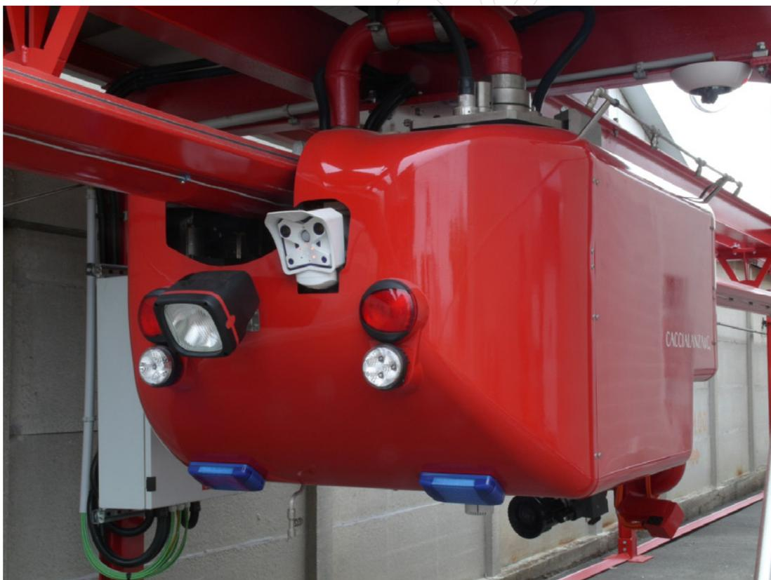
Nella struttura fissa è integrata la tubazione in pressione (~10 bar) per alimentazione di acqua o di miscela schiumogena antincendio.
