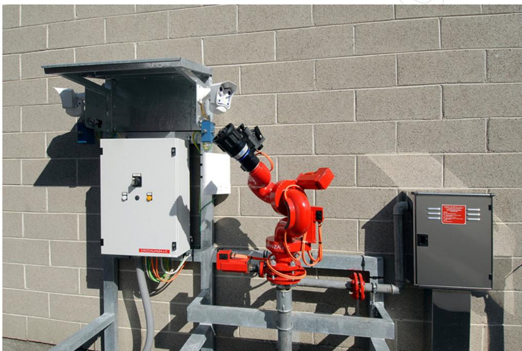
Anche in questo caso la comunicazione e il controllo delle unità avviene su bus seriale e la rilevazione mediante cavo termosensibile e rilevatori di fiamma a infrarosso.
