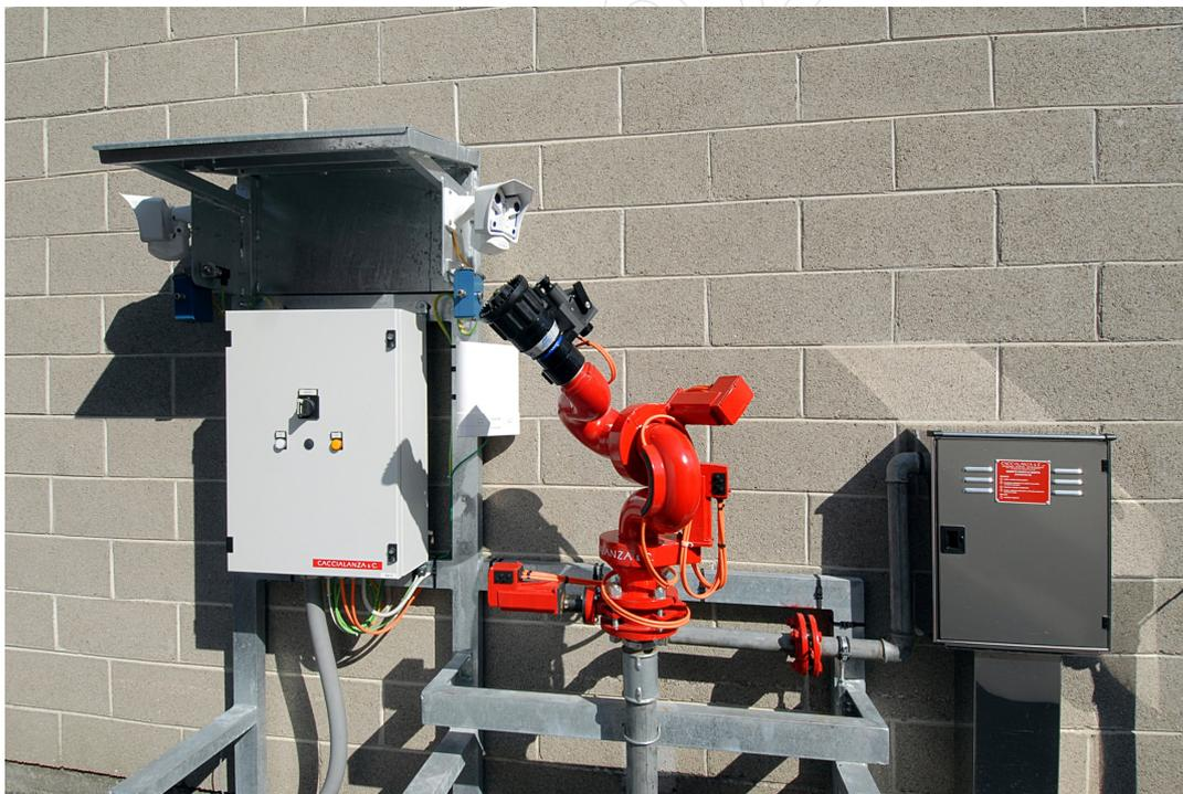
I monitori sono telecomandati elettricamente sia per i movimenti di alzo e rotazione che per la regolazione del bocchello da getto pieno a getto frazionato e per la apertura e chiusura della valvola a farfalla integrata.
