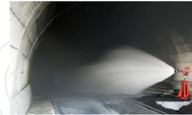
A intervalli regolari (tipicamente 42 metri) lungo la parete della galleria sono distribuite stazioni di intervento e controllo costituite da un monitor telecomandato da 1.000 lt./min. con valvola motorizzata, un quadro elettrico, rilevatori di fiamma e telecamere a luce visibile e infrarossa.
