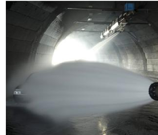
Il sistema è costituito da una struttura fissa (rotaia aerea) installata lungo l'intera tratta della galleria e percorsa da strutture mobili con montati a bordo monitori idroschiuma che traslano lungo la struttura fissa.
